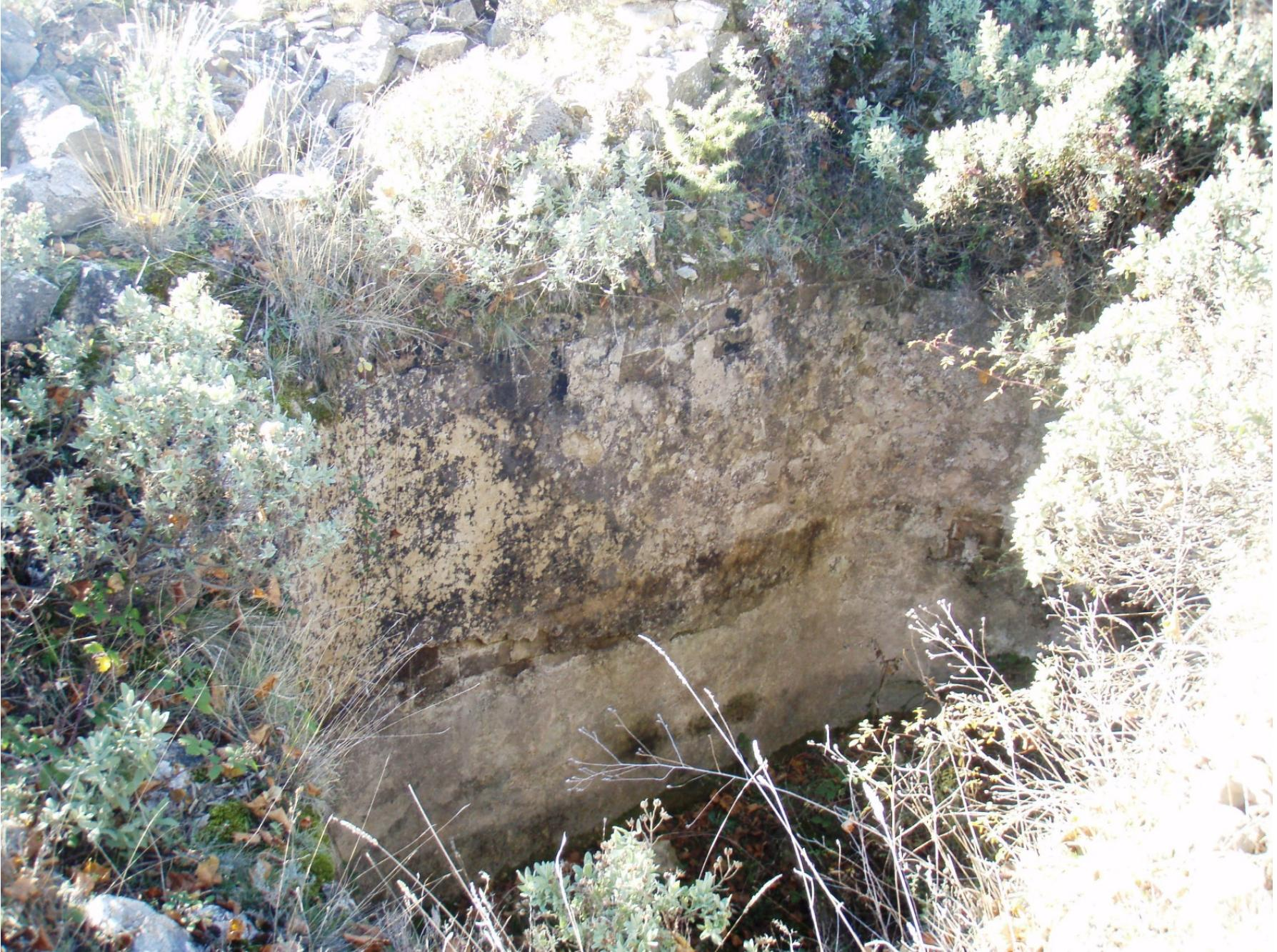
La ferme de Peymia possède une citerne d'une grande capacité, dont les parois ont été rendues étanches par un « béton de tuileau ». Environ 80 m<sup>3</sup> d'eau pouvaient être recueillis par un système de gouttière recueillant la pluie tombant sur la toiture.
